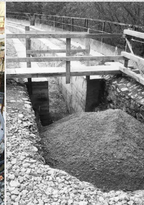
PONTE A 7 ARCHI PR. Km 65+805 – Consolidamento muri andatori con placcaggio esterno e collegamento trasversale con barre in acciaio; realizzazione muri di sostegno sulla sede ferroviaria
