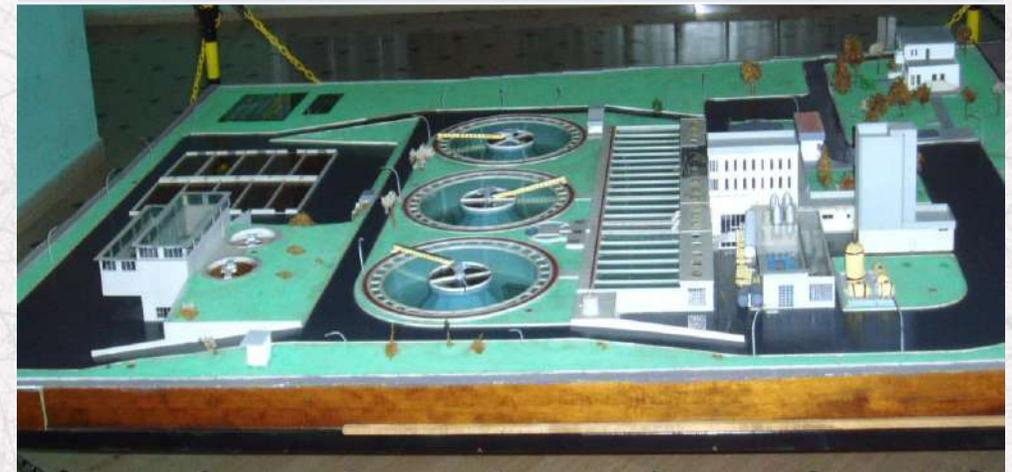
IMPIANTO DI POTABILIZZAZIONE – Plastico con Vasche di sedimentazione e Filtri
