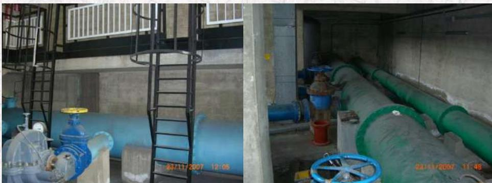
**RILIEVO FOTOGRAFICO** – Condotta di alimentazione DN 700 (a sx) e condotte prementi DN 900 per Sant'Eleuterio e DN 500 per Fusco (a dx)
