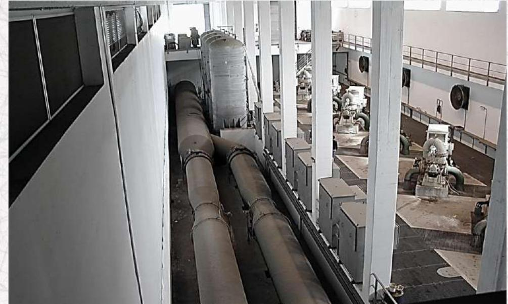
CAMERA DI MANOVRA DEL SERBATOIO: CONDOTTA DN 2400 DI ALIMENTAZIONE – Fotografia
